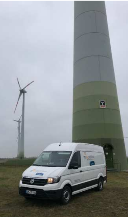
ENERTRAG Service-Fahrzeug vor Enercon E 66
